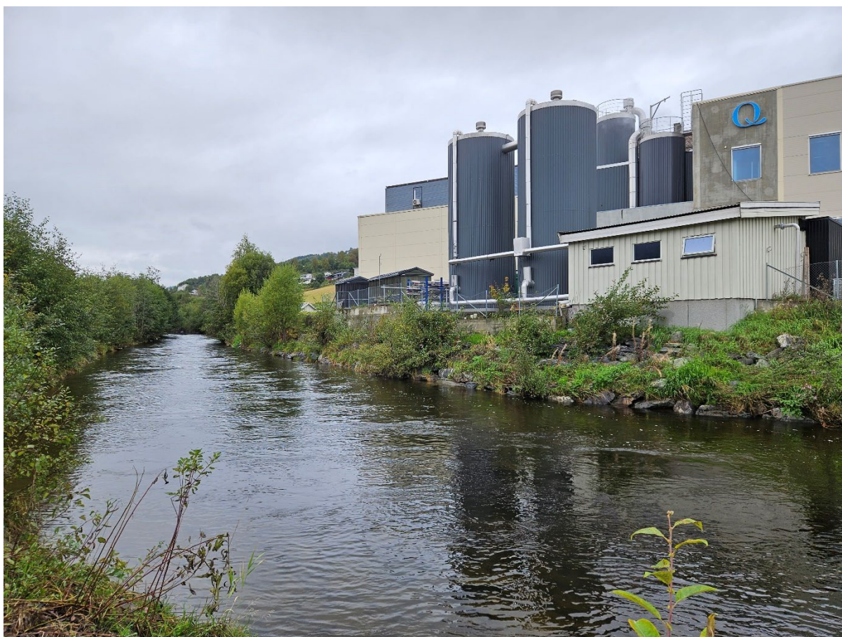
Figur 5. Bilde tatt oppstrøms, fra prosjektert innløp for ny elvestrekning. Kanaliseringen er tydelig, og erosjonssikring med grov stein ses langs Q-meieriet. Foto: Naturrestaurering AS.
