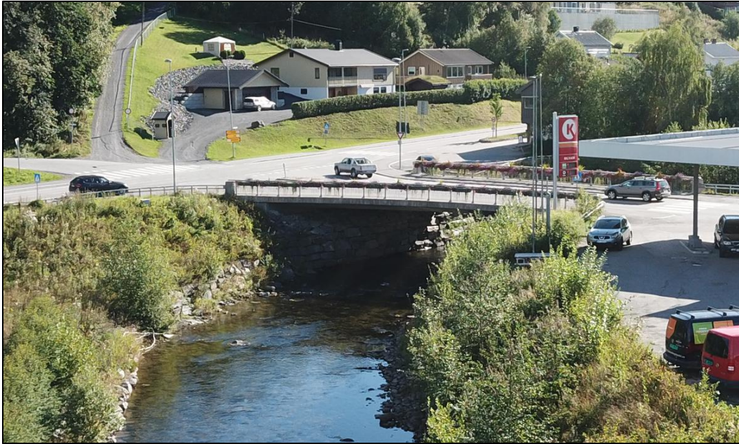
Figur 7: Bilde av brua der Vestringsvegen krysser Gausa.
