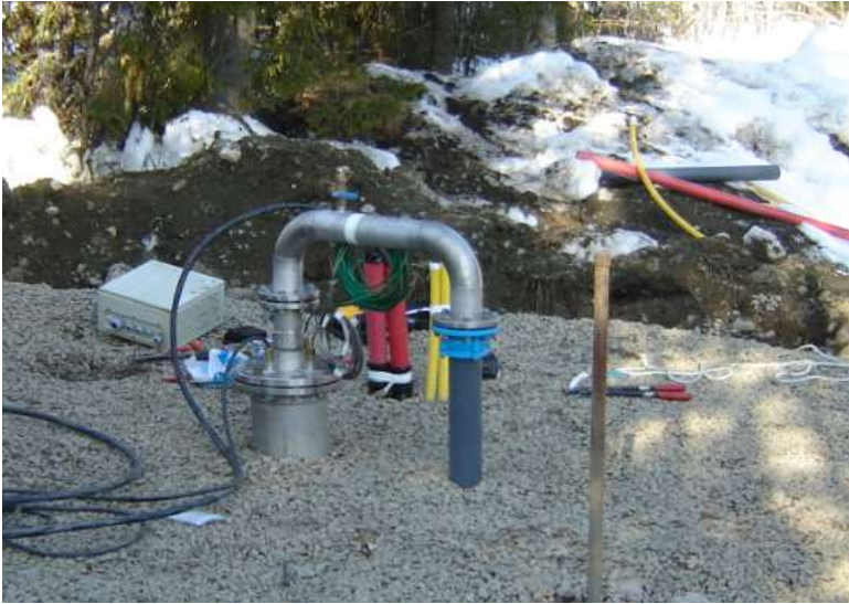
Figur 5-1 Etablering av en grunnvannsbrønn ved Forset i 2008
