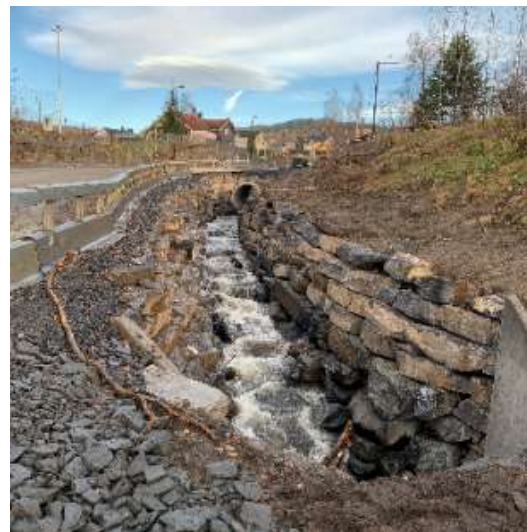
Figur 12-1 Bekkeløp med terskler i Heggen boligfelt (til venstre), og Finna med murt bekkeløp langs Kveinnvegen.
