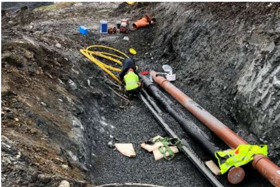
Figur 10-7 Utførelse av saneringsprosjekt i Follebu (Follebu Bil – Kolbotnvegen)
