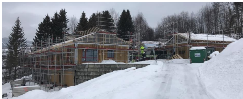
Bildet over viser bygging av nye omsorgsboliger for yngre personer i Heggenfeltet i Follebu. Omsorgsboligene har fått navnet Heggelia.
