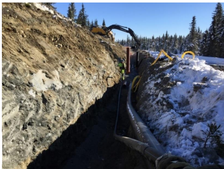
Bildet viser rehabilitering av vann-/avløpsledninger i Skeislia.
