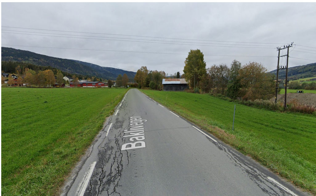
Figur 35 Baklivegen sør for masseinntaket, sør for Fjerdumsskogen boligområde
