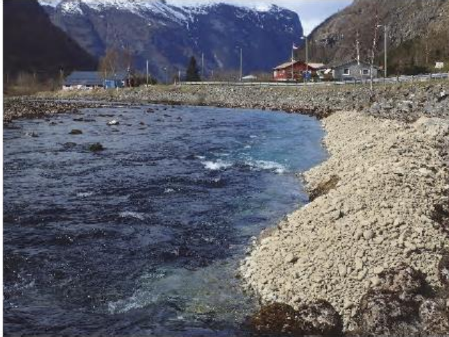
Figur 31: Eksempel på utlegging av eroderbart grusmateriale i Lærdalselva (NORCE, 2022)
